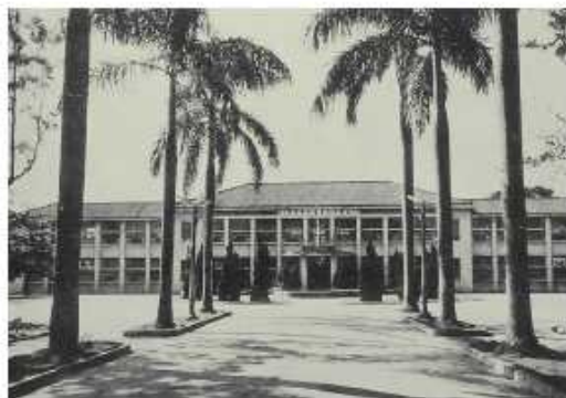
1955年7月新校區第一棟大樓竣工
