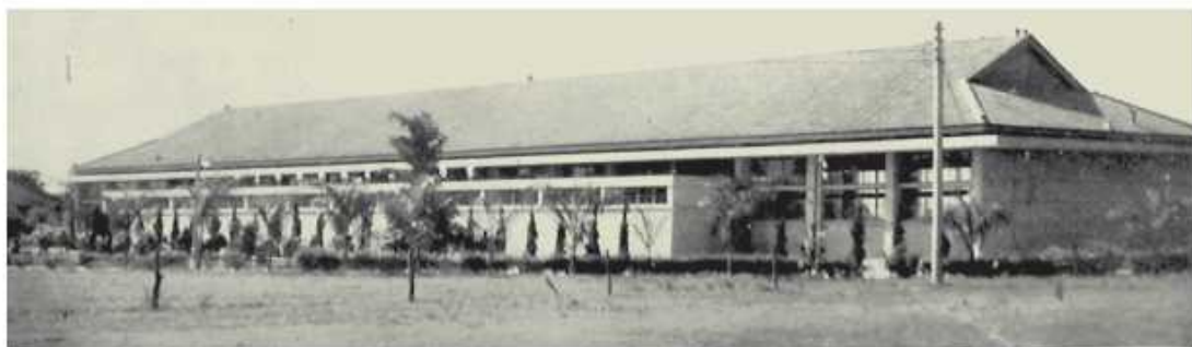
農業機械訓練中心成立廠房全貌
